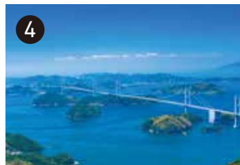
しまなみ海道の橋
