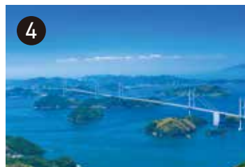
しまなみ海道の橋
